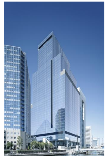
BLUE FRONT SHIBAURA TOWER S 外観写真
