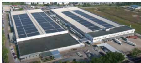
生産拠点の敷地内に太陽光発電システム(設置面積17,059平方メートル、発電容量3.4MW)を導入
